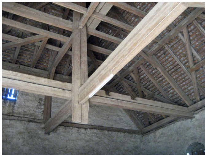
Unzugänglicher Teil des Dachstuhls
