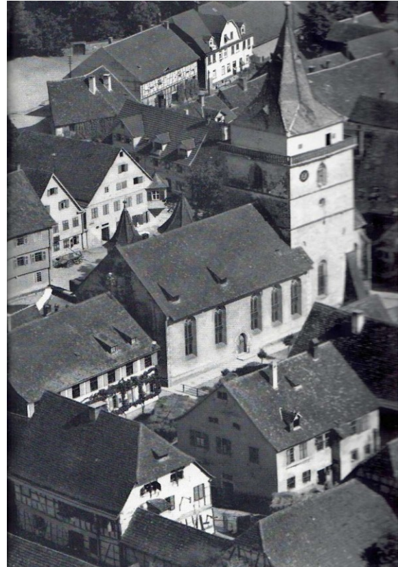
Stadtkirche 1927. Zwei Dachgauben sind noch erhalten. Bild: Landkreis Ludwigsburg
